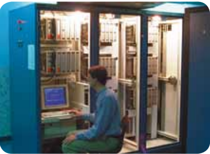
九套冗余热备的 Modicon 984-785 控制器和远程 I/O
