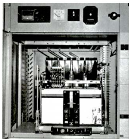
disjoncteur Selpact débrochable
