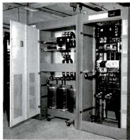
transformateur de séparation des circuits BT et différentes possibilités d'équipement
