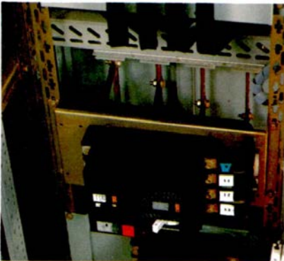
Exemples de raccords de l'appareillage sur un jeu de barres
