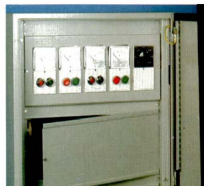
Fermeture d'un module par plastron
