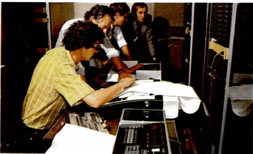
Mise en service sur le site
