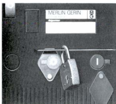
Verrouillage de la manœuvre locale du disjoncteur
